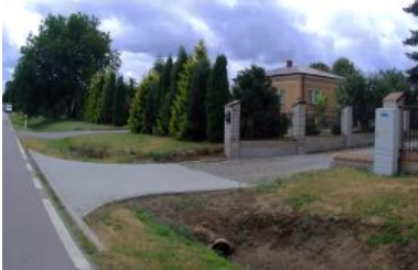
Fot. 216 Zjazd Indywidualny prawy w km 10+245,25.
