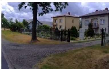
Fot. 204 Zjazd Indywidualny prawy w km 9+920,47.
