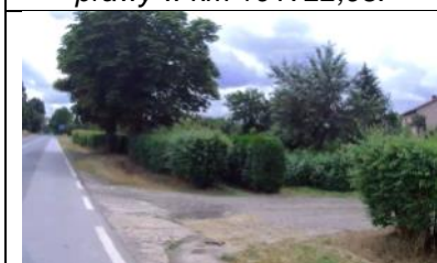
Fot. 237 Zjazd Indywidualny prawy w km 10+880,14.
