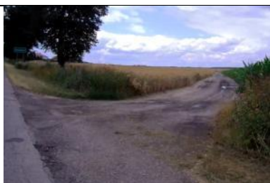
Fot. 58 Zjazd Publiczny lewy w km 4+258,87.
