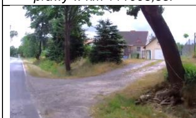
Fot. 246 Zjazd Indywidualny prawy w km 11+082,87.
