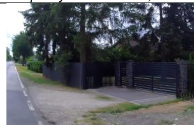
Fot. 227 Zjazd Indywidualny prawy w km 10+488,40.
