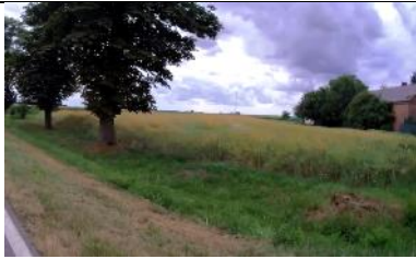
Fot. 52 Zjazd Indywidualny prawy w km 4+074,39.
