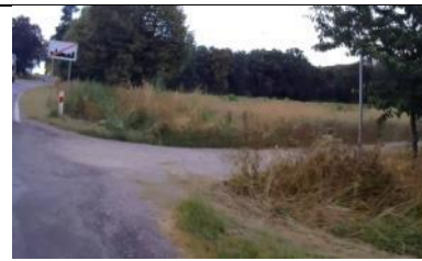
Fot. 153 Zjazd Publiczny lewy w km 7+516,80.
