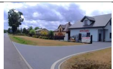
Fot. 206 Zjazd Indywidualny prawy w km 9+972,76.
