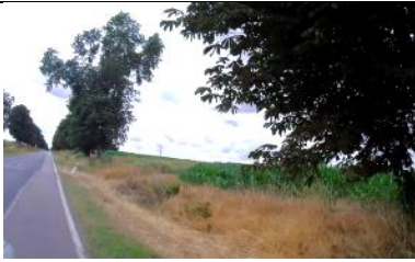
Fot. 16 Zjazd Indywidualny prawy w km 3+149,53.
