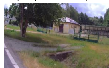
Fot. 248 Zjazd Indywidualny prawy w km 11+214,38.
