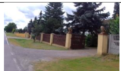
Fot. 212 Zjazd Indywidualny prawy w km 10+172,95.
