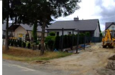
Fot. 220 Zjazd Indywidualny prawy w km 10+350,90.
