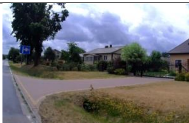
Fot. 207 Zjazd Indywidualny prawy w km 10+011,19.
