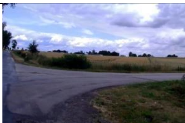
Fot. 118 Skrzyżowanie lewe w km 6+369,39.
