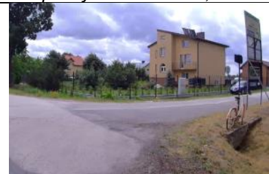
Fot. 230 Skrzyżowanie prawe w km 10+562,77.
