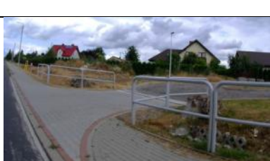
Fot. 199 Zjazd Publiczny lewy w km 10+018,14.
