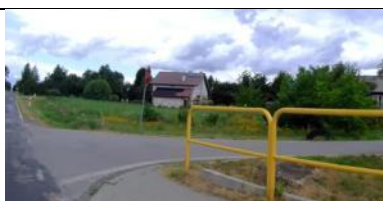
Fot. 196 Skrzyżowanie lewe w km 9+885,00.
