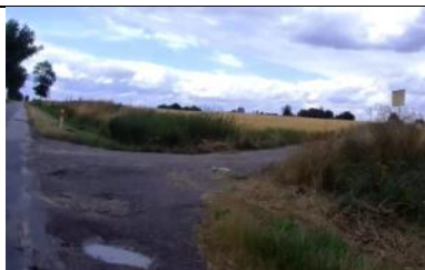
Fot. 115 Zjazd Publiczny lewy w km 6+268,56.
