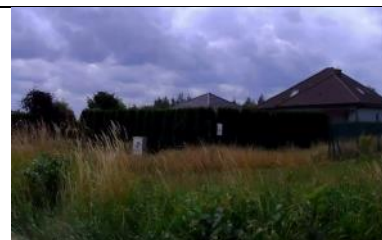
Fot. 189 Zjazd Indywidualny prawy w km 9+531,59.
