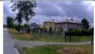
Fot. 203 Zjazd Indywidualny prawy w km 9+897,18.
