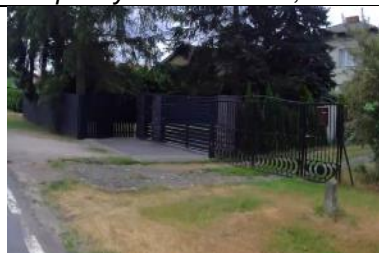
Fot. 226 Zjazd Indywidualny prawy w km 10+483,90.
