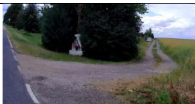
Fot. 47 Zjazd Publiczny lewy w km 3+948,60.
