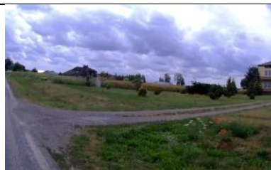
Fot. 185 Zjazd Indywidualny prawy w km 9+411,26.
