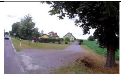
Fot. 42 Zjazd Indywidualny prawy w km 3+766,84.
