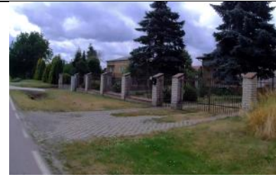
Fot. 215 Zjazd Indywidualny prawy w km 10+224,82.
