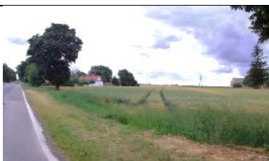
Fot. 46 Zjazd Indywidualny prawy w km 3+914,96.
