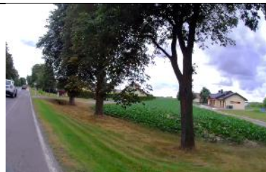
Fot. 41 Zjazd Indywidualny prawy w km 3+747,72.
