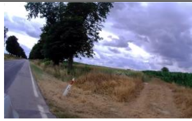
Fot. 17 Zjazd Indywidualny prawy w km 3+166,23.
