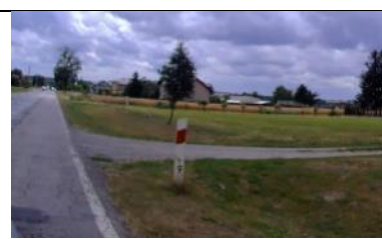
Fot. 195 Zjazd Indywidualny prawy w km 9+763,60.
