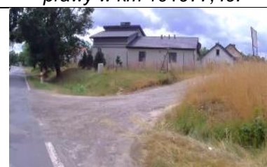
Fot. 245 Zjazd Indywidualny prawy w km 11+049,93.
