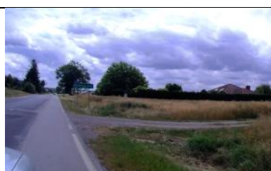
Fot. 191 Zjazd Indywidualny prawy w km 9+583,02.
