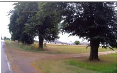
Fot. 181 Zjazd Indywidualny prawy w km 9+324,54.
