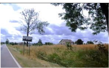
Fot. 193 Zjazd Indywidualny prawy w km 9+684,92.
