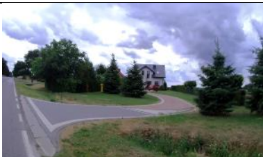
Fot. 31 Zjazd Indywidualny prawy w km 3+488,69.
