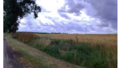
Fot. 60 Zjazd Indywidualny prawy w km 4+262,53.
