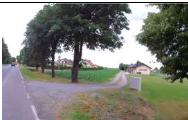
Fot. 40 Zjazd Indywidualny prawy w km 3+729,47.
