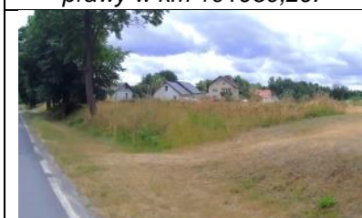
Fot. 243 Zjazd Indywidualny prawy w km 11+003,55.
