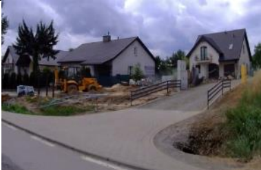
Fot. 219 Zjazd Indywidualny prawy w km 10+335,79.
