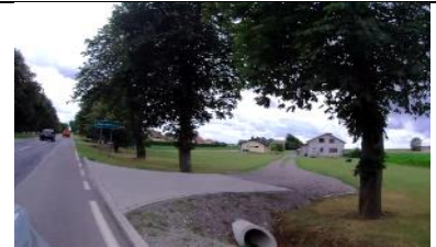
Fot. 39 Zjazd Indywidualny prawy w km 3+695,69.
