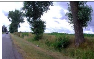
Fot. 62 Zjazd Indywidualny prawy w km 4+306,17.
