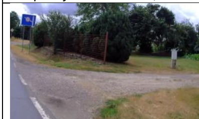
Fot. 240 Zjazd Indywidualny prawy w km 10+950,29.
