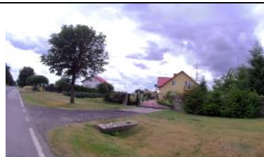
Fot. 32 Zjazd Indywidualny prawy w km 3+521,08.
