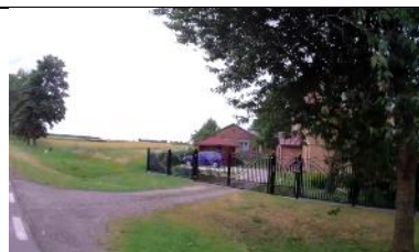
Fot. 50 Zjazd Indywidualny prawy w km 4+022,23.
