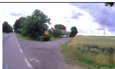
Fot. 47 Zjazd Indywidualny prawy w km 3+926,17.
