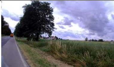
Fot. 37 Zjazd Indywidualny prawy w km 3+641,06.
