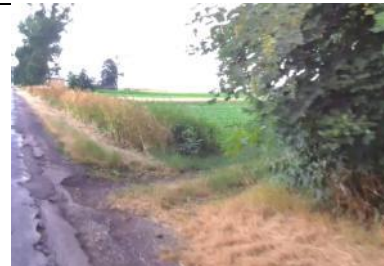
Fot. 147 Zjazd Publiczny lewy w km 7+351,81.
