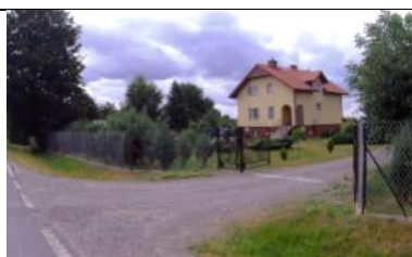
Fot. 232 Zjazd Indywidualny prawy w km 10+620,28.
