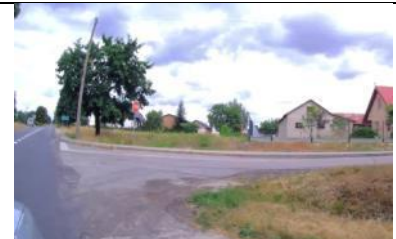
Fot. 228 Skrzyżowanie lewe w km 11+024,05.
